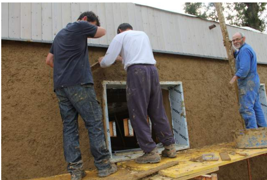
La terre de terrassement a été récupérée sur place pour fabriquer les enduits.
