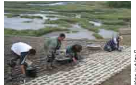
Le chantier d'insertion participe à la restauration des cales.
