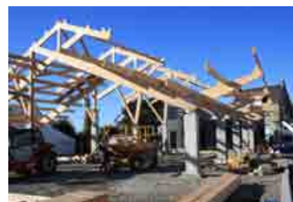
La halle en construction avec les piliers de granit et la charpente en bois
