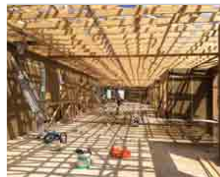
La réalisation de l'ossature a été en bois sitka de Bretagne, avec le concours d'Abibois
